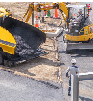
◀道路の復旧工事（イメージ）
